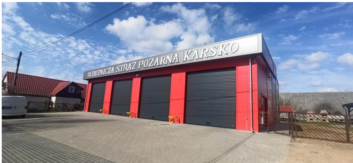
Budowa nowego budynku remizy w m. Karsko
