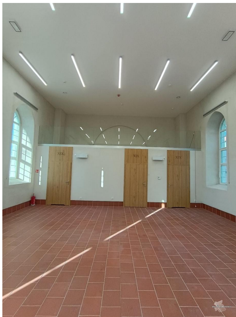
Przebudowa i odbudowa dawnego obiektu sakralnego w Giżynie
