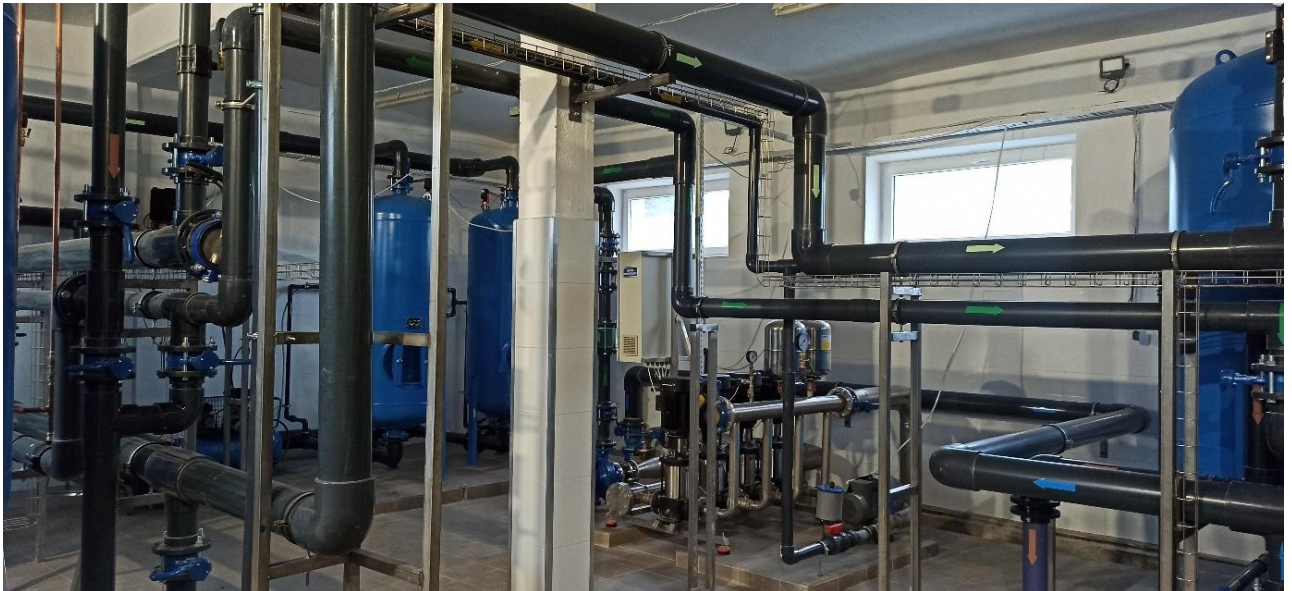
Przebudowa stacji wodociągowych z infrastrukturą towarzyszącą w m. Golin i Karsko
