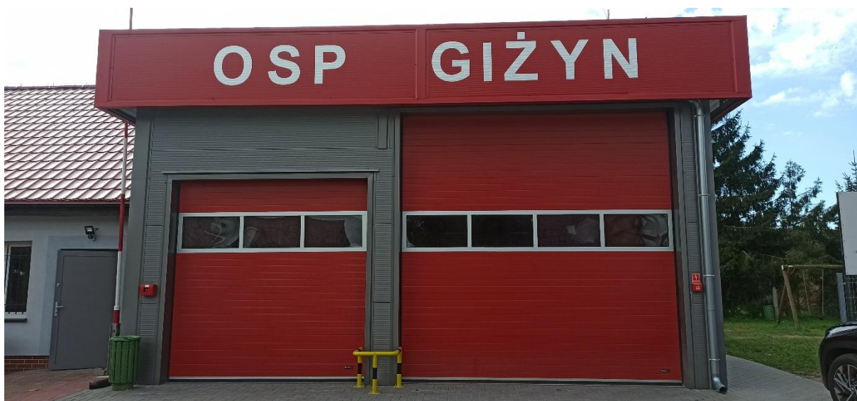
Rozbudowa remizy strażackiej w m. Giżyn
