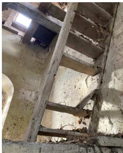
Nr 26, Nr 27 Detal. Strefa wieży. Prowizoryczny zdegradowany sposób dojścia do strychu.
