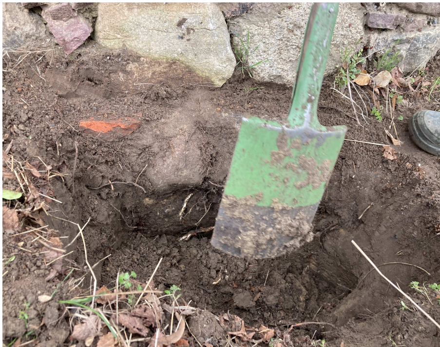
Nr 13 Odkrywka fundamentowa w strefie elewacji południowej z widocznymi wrośniętymi korzeniami pobliskiego drzewa w przestrzenie między kamieniami.
