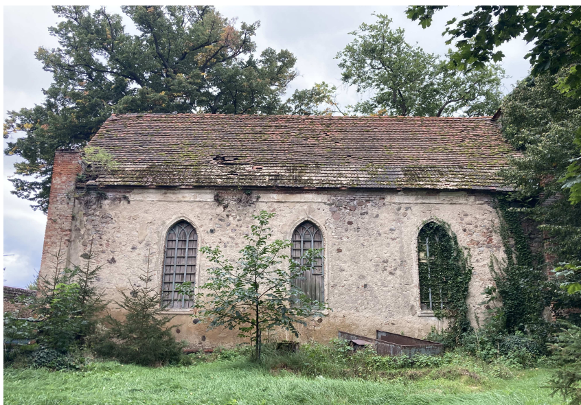
Nr 5 Elewacja północna. Widok obiektu w stanie skrajnego zniszczenia murów, dachu, okien.
