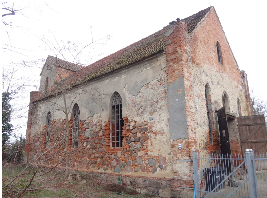
Nr 3 Stan elewacji południowo- wschodniej. Pozostałości tynku, odsłonięta zawilgocona konstrukcja murów, otwory okienne ze szczątkowymi drewnianymi.
